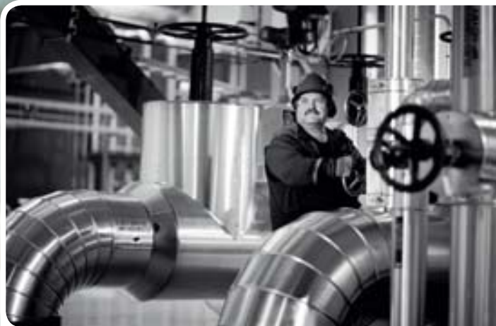
Finno kraftvärmeverk, som invigdes 2009, minskar utsläppen betydligt i Esbo, Finland, genom att använda naturgas som bränsle.
