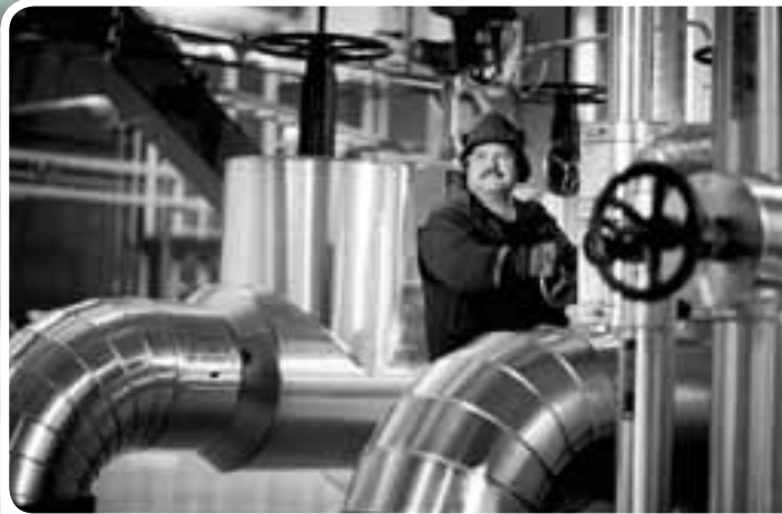
Suomenojan CHP-laitos, joka avattiin vuonna 2009, käyttää polttoainena maakaasua ja vähentää päästöjä merkittävästi Espoon alueella.
