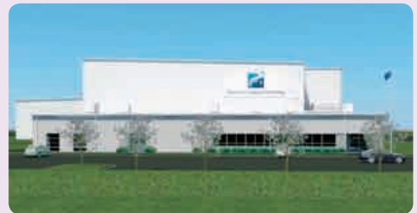
樹脂コンパウンド工場の外観
