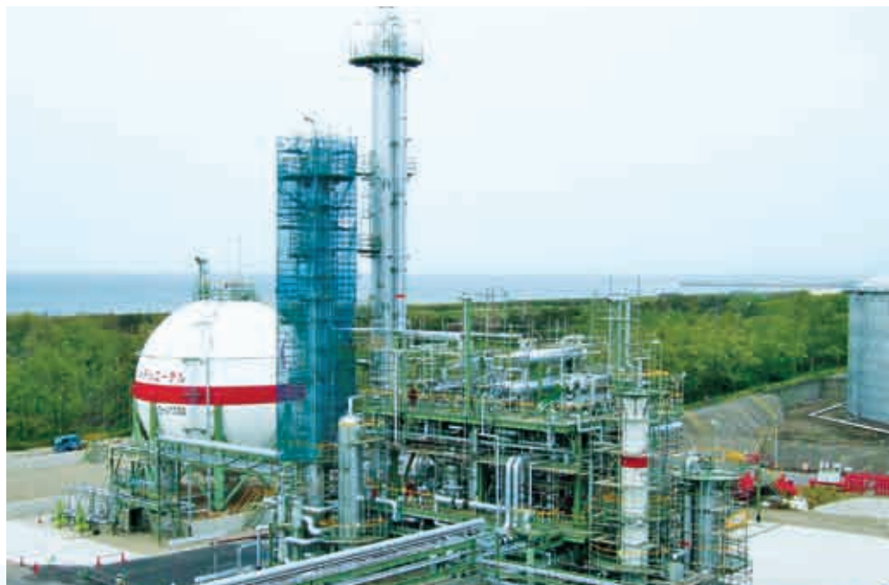
当社が出資参画する燃料DME（ジメチルエーテル）製造会社の普及促進プラント（年間8万トンの生産能力を有し、2009年初めに試運転を終え、初出荷を行った）
