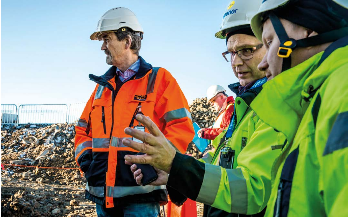
Uponorin Weholite®-putkea asennettiin Ruotsin Boråsin uuteen jätevesilaitokseen, jossa turvalliset putket ja liittimet ovat olennaisia.
