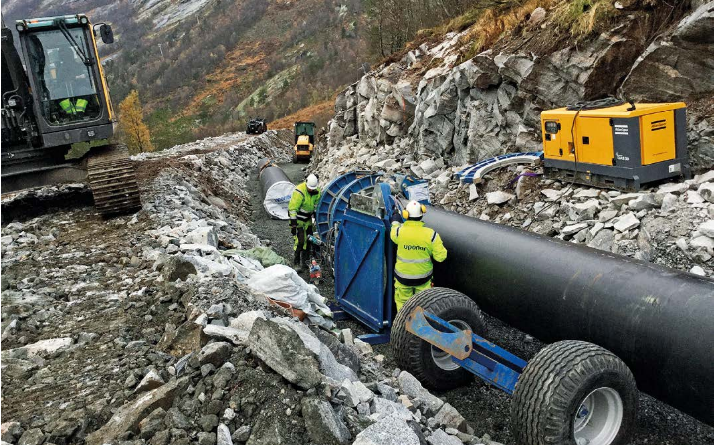
1,8 km Uponorin 1 000 mm paineputkea asennettiin vaativaan maastoon Norjan Glomfjordissa, kun lannoitteiden valmistaja Yara International uudisti vedenjakelun tehtaalleen.
