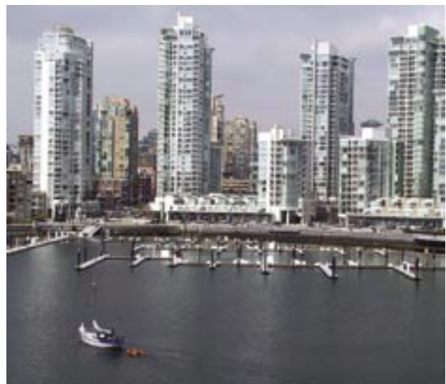
Vancouverissa Kanadassa sijaitsevista Concord Pacific Vista -asuin- ja toimistotaloissa on Wirsbo AquaPex -käyttövesijärjestelmä.
