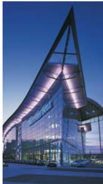
Velta Contec -lämmitys- ja jäähdytysjärjestelmä on asennettu Mercedes Welt -rakennukseen Berliinissä.
