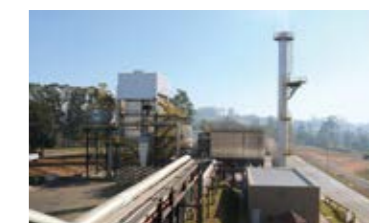
The Limeira Plant (Brazil)
