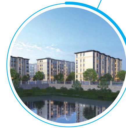
南京遠洋山水 項目區位：江蘇省南京市江寧區 總建築面積：147,000平方米
