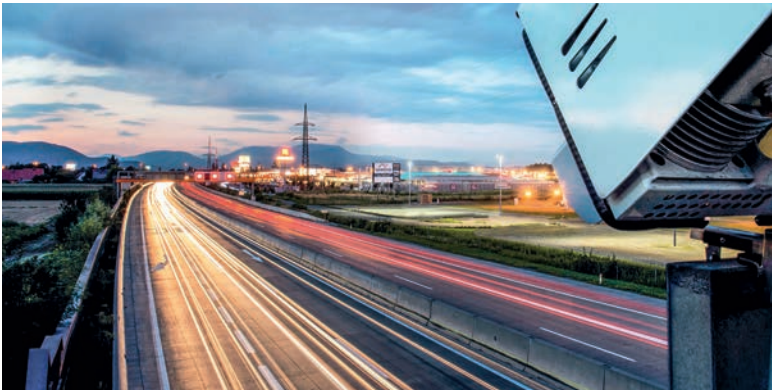
Vollautomatische Kontrollsysteme funktionieren ohne Unterbrechung des Fließverkehrs.
