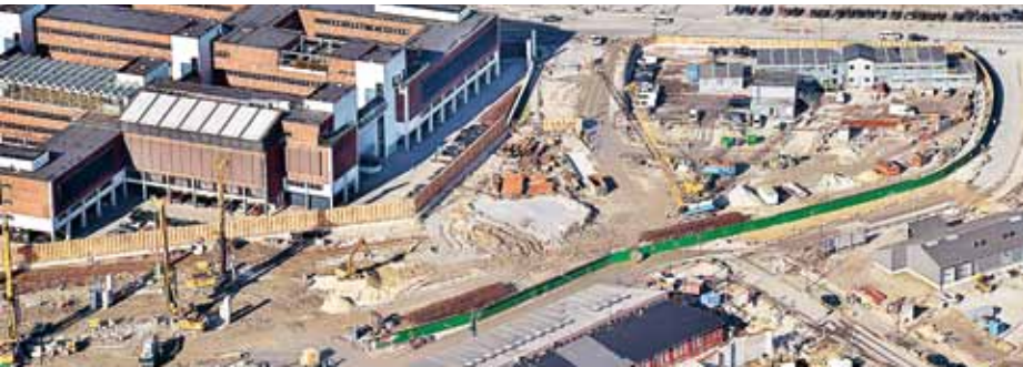
Bau eines 2 km langen U-Bahn-Tunnels
