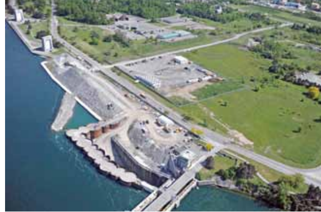
Bau Niagara Tunnel-Projekt
