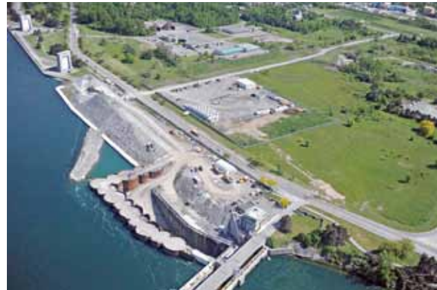
Bau Niagara Tunnel-Projekt
