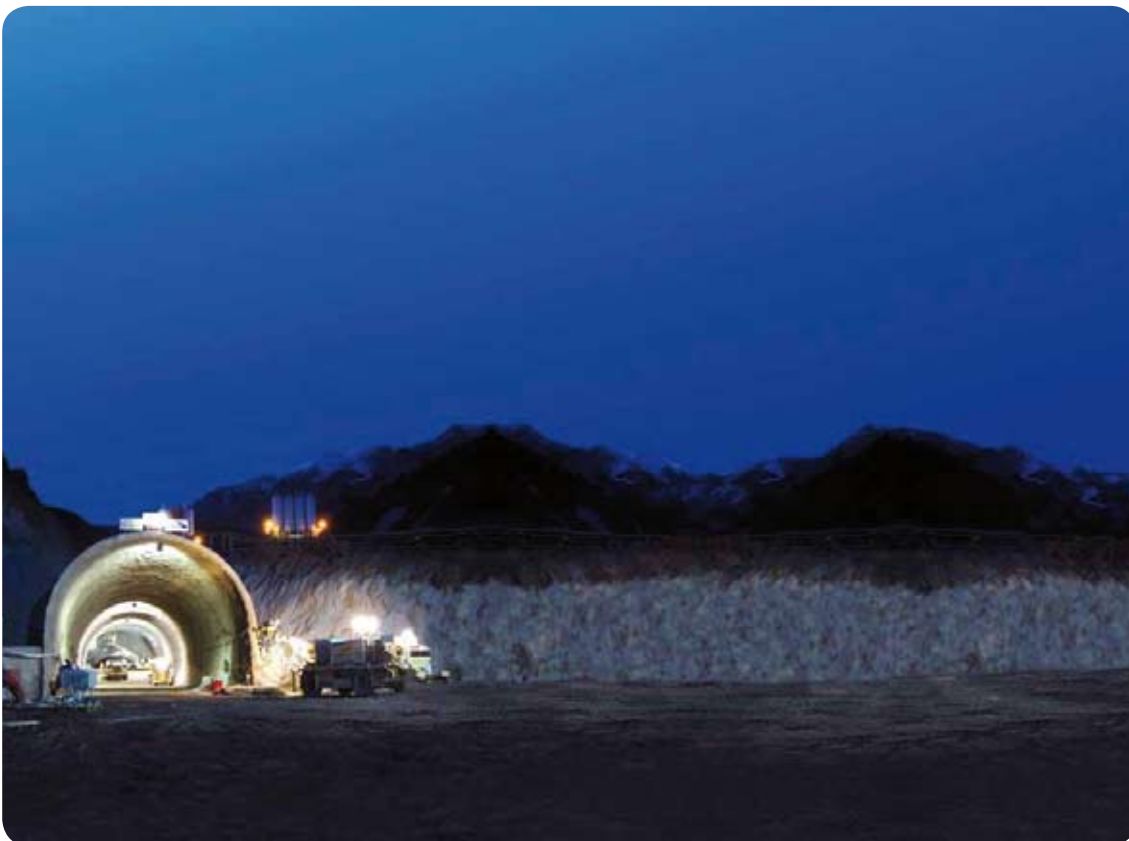
Eisenbahntunnel Brixlegg, Österreich
