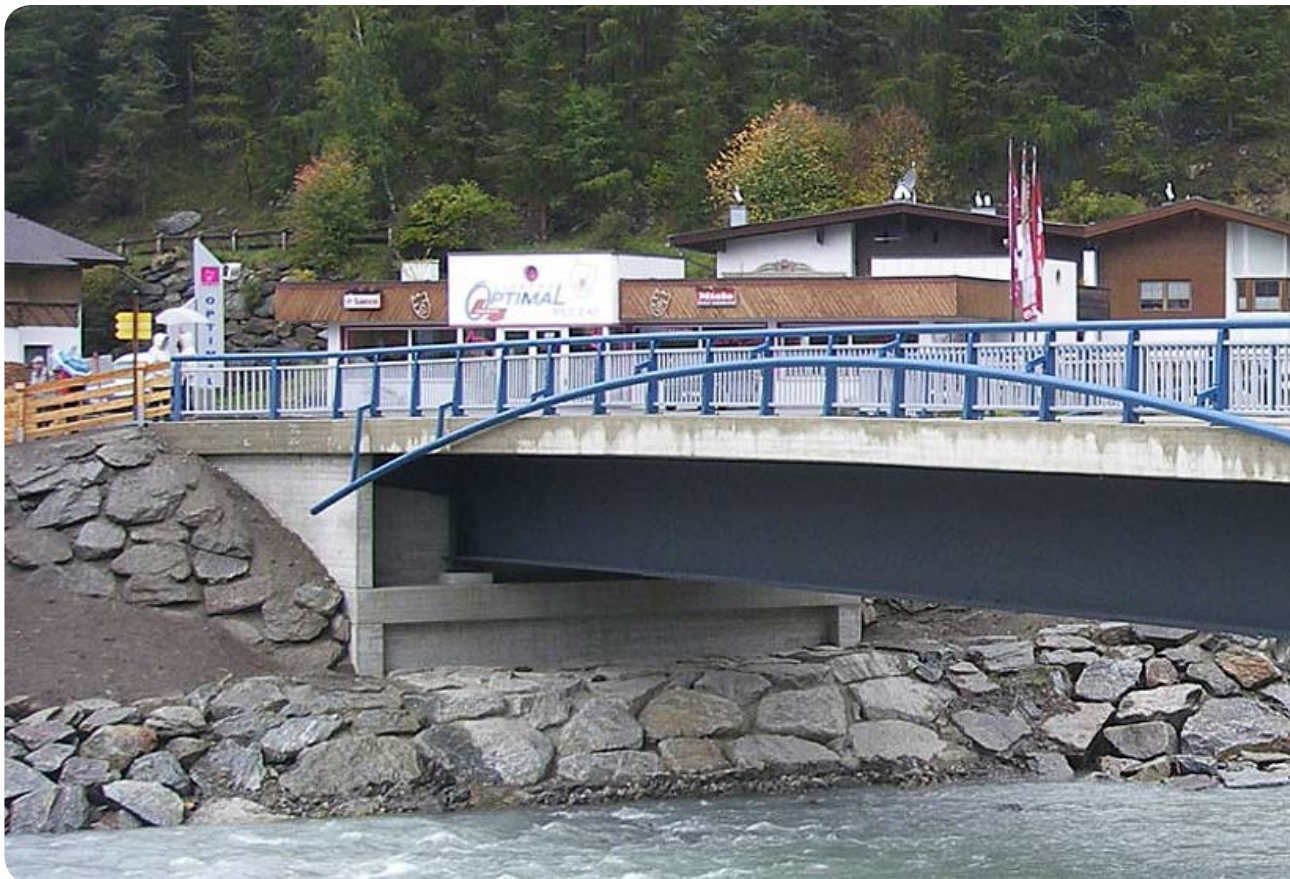
Nesselachbrücke Längenfeld, Tyrol, Austria
