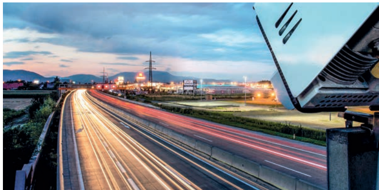
Vollautomatische Kontrollsysteme funktionieren ohne Unterbrechung des Fließverkehrs.
