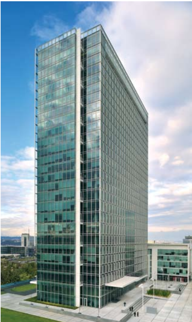
DER CITY TOWER IN PRAG IST MIT 109 METERN DAS HÖCHSTE BÜROGEBÄUDE IN TSCHEDIEN UND HAT FAST 50.000 m 2 NUTZFLÄCHE.
