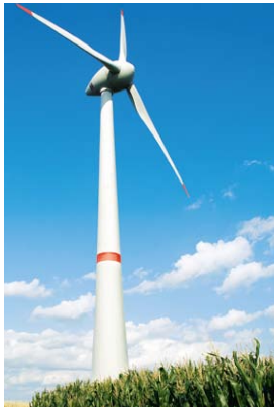
WINDPARK LARRELTHER POLDER IN EMDEN, DEUTSCHLAND
