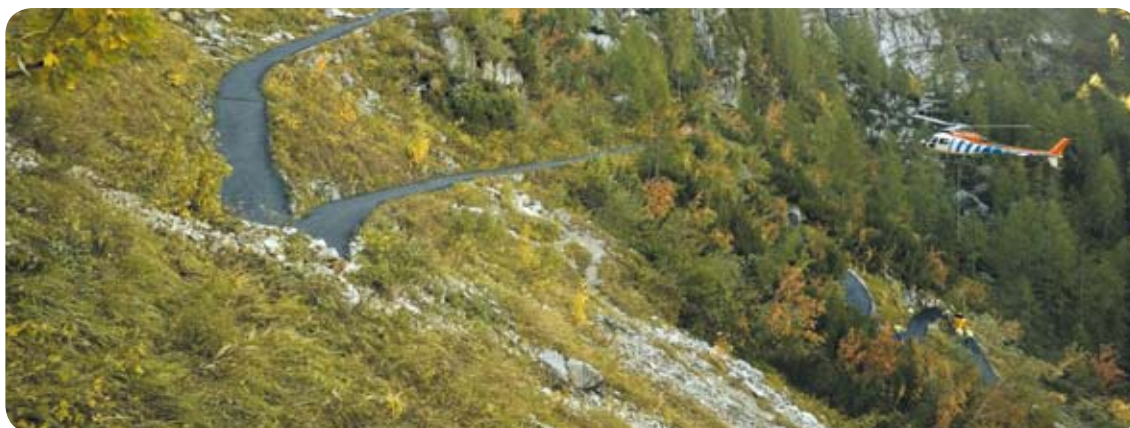
Asphaltierung Zugang Höhlensystem Dachstein, OÖ, Österreich
